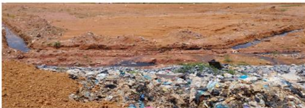
Figura 2-Acúmulo de chorume
